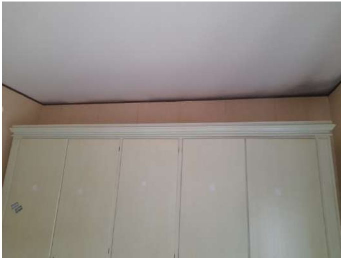
Alcune macchie di umidità presenti al soffitto del secondo piano
