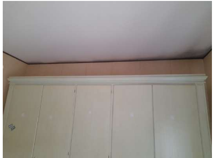
Alcune macchie di umidità presenti al soffitto del secondo piano
